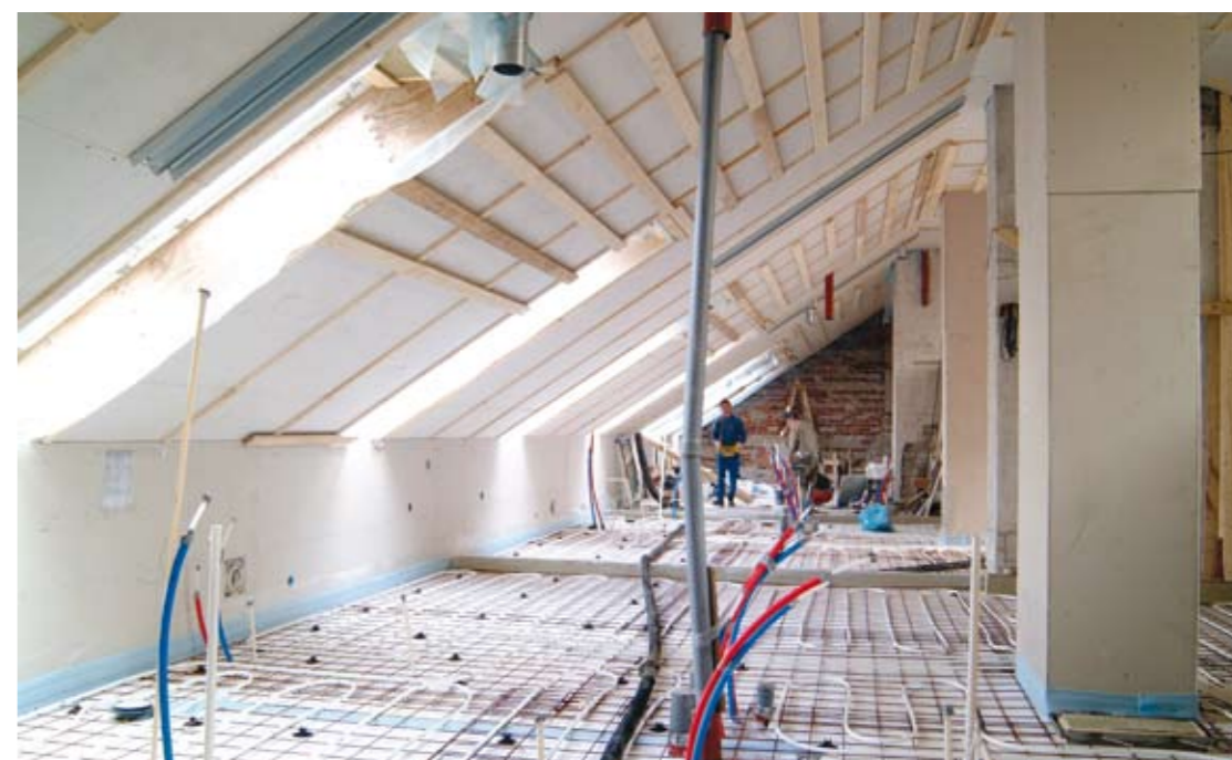
PEX vamzdžiai vandentiekio ir šildymo sistemoms gaminami su deguonies difuzijos barjeru, kuris užkerta kelią metalinių sistemų dalių (radiatorių, katilų ir kitų) korozijai
