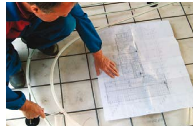
Specialus vamzdis grindų šildymui pe-PEX turi papildomą apsauginį sluoksnį nuo deguonies difuzijos barjero mechaninio pažeidimo
